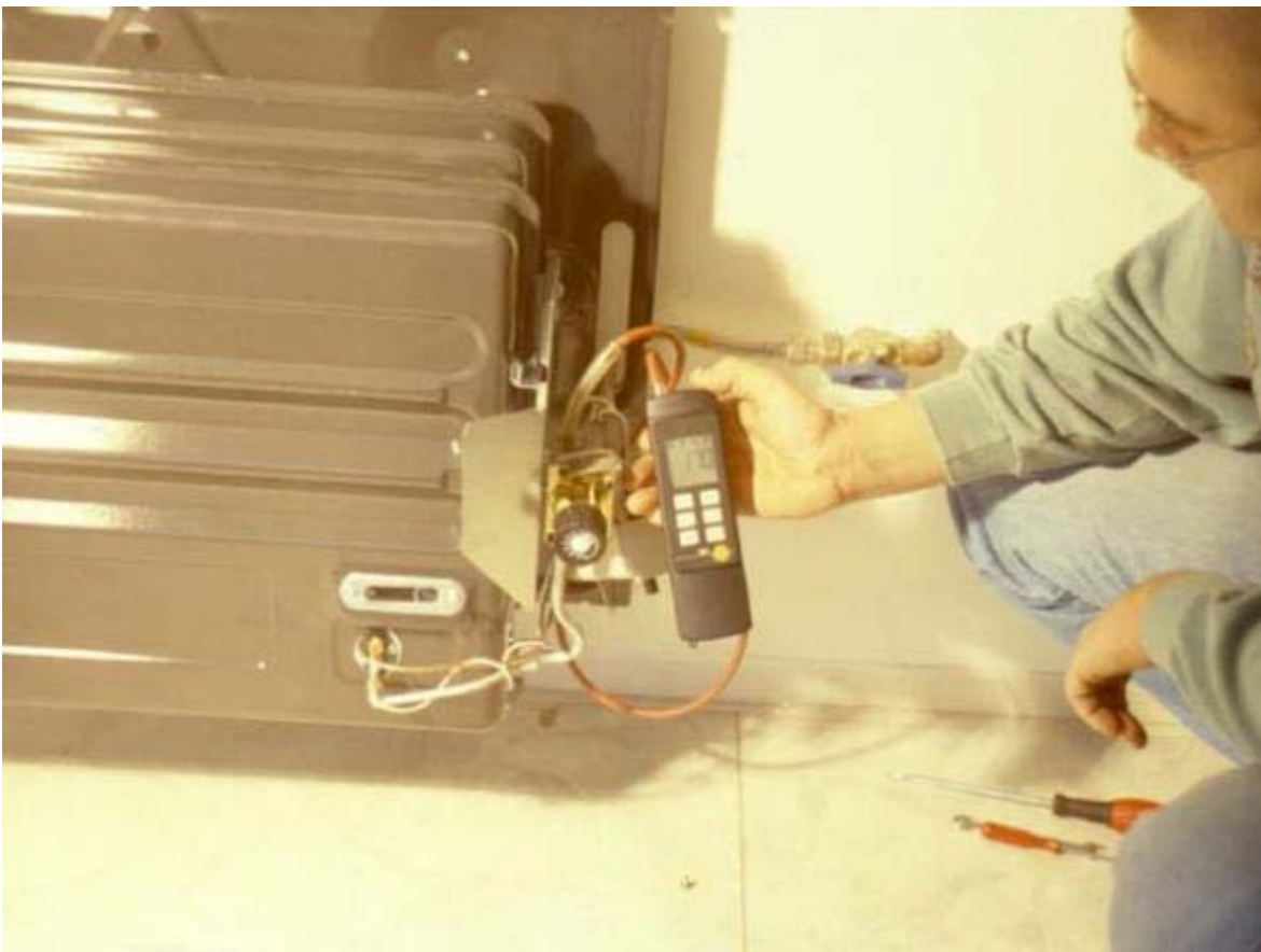
8. Измерение давления на основной горелке (при полной нагрузке)
